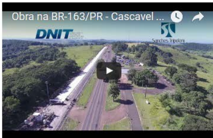
Obra na BR-163/PR - Cascavel - Fevereiro 2017
