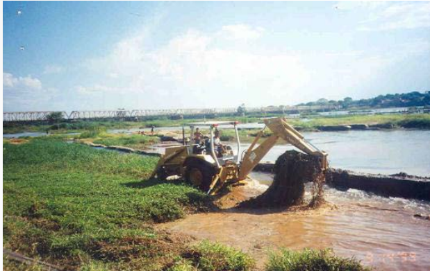
Limpeza do Canal de Captação
