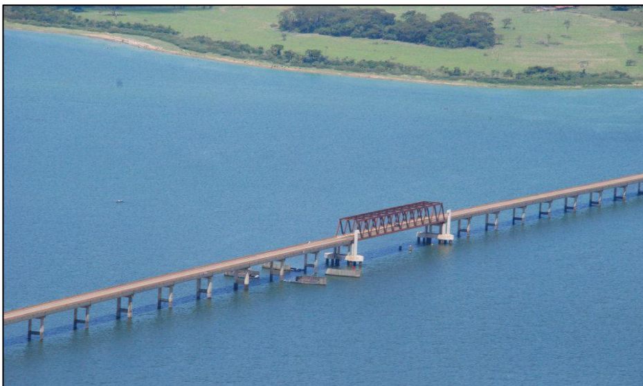
Ponte SP-333 – proteção de pilares
