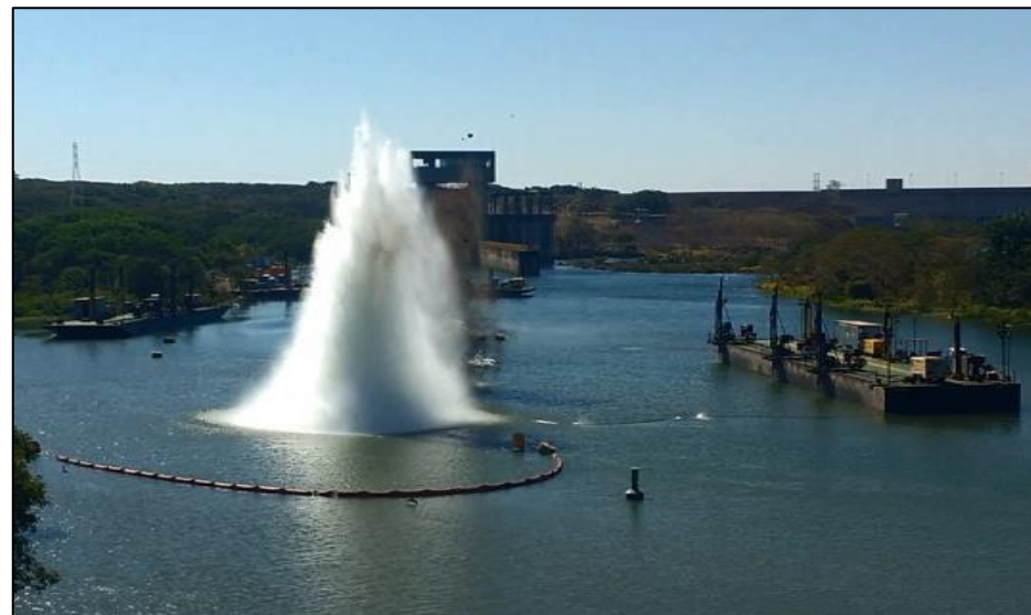
Derrocamento a jusante de Nova Avanhandava
