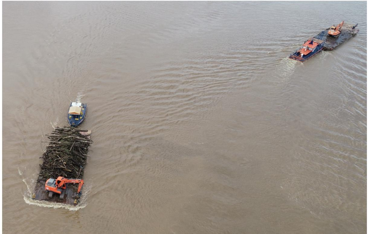
Balsas operando na retirada dos troncos dos Log Boom em direção ao vertedouro.
