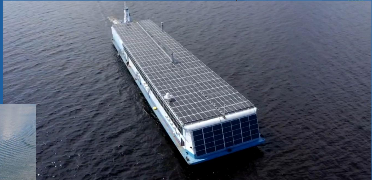
Usina Beneficiadora Flutuante de Açaí - TBL
